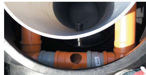
рисунок 2 Переливная система в стакане биофильтра Rostok»Плюс
